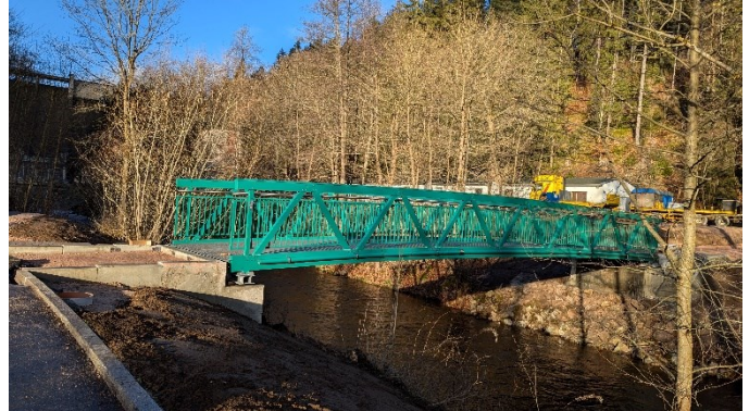
Das neue Bauwerk wurde in den Farben des Mulderadweges gestaltet und fügt sich sehr gut in die Umgebung ein. (Fotos: ZV)
