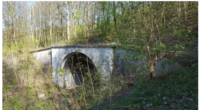
Das Tunnelportal West im Ortsteil Bad Schlema stellt eine besondere Herausforderung dar, denn der Mulderadweg muss hierüber geführt werden. Die Absturzsicherung muss angebracht werden
