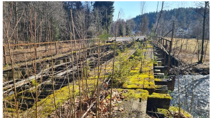
Die Aufbauten auf der Brücke in Wolfsgrün werden komplett entfernt und entsorgt. Diese können für den Radwegebau nicht genutzt werden.
