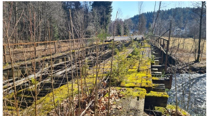
Die Aufbauten auf der Brücke in Wolfsgrün werden komplett entfernt und entsorgt. Diese können für den Radwegbau nicht genutzt werden.
