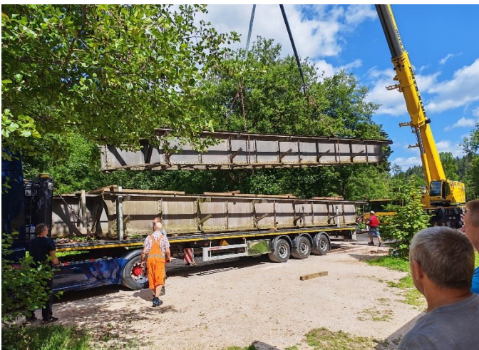
Verladung der Trägerkonstruktion zur Korrosionsschutzbehandlung (Foto: „Rüdiger Baugesellschaft mbH“)
