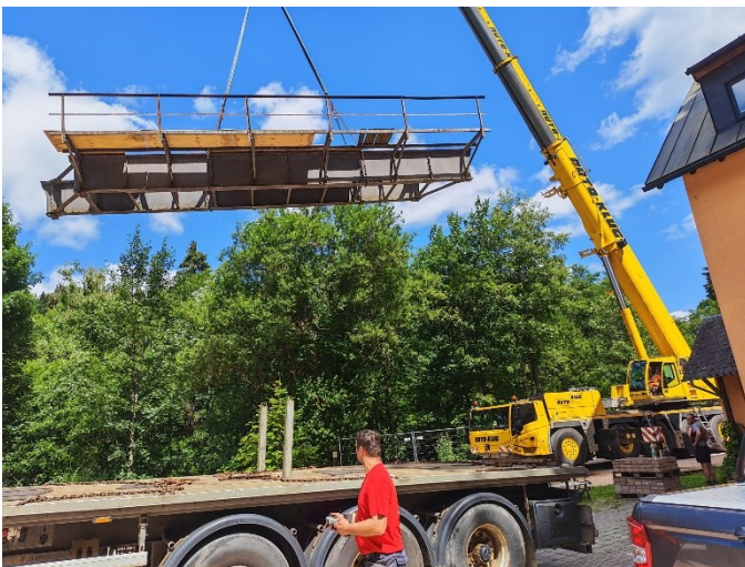
Verladung der Trägerkonstruktion zur Korrosionsschutzbehandlung (Foto: „Rüdiger Baugesellschaft mbH“)
