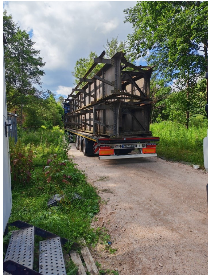
Verladung der Trägerkonstruktion zur Korrosionsschutzbehandlung (Foto: „Rüdiger Baugesellschaft mbH“)
